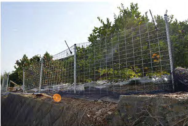
●鳥獣対策のため設置した電気柵
