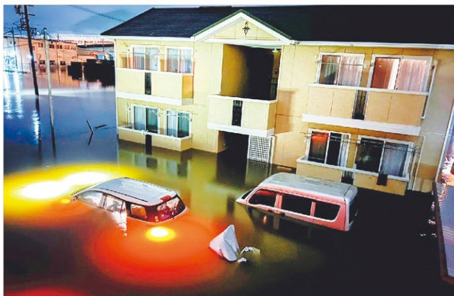
浸水被害に遭ったアパート
